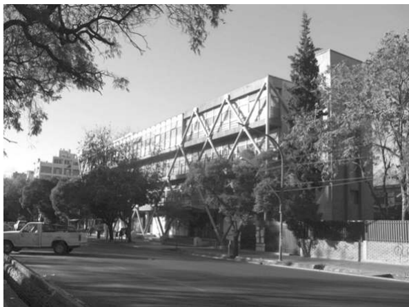
Figura 12.5 – Vista Escuela Normal rehabilitada, ciudad de Mendoza.
