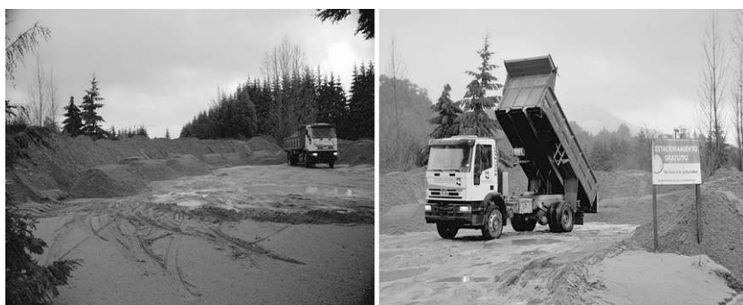
Figura 15.4 – Operación de descarga de ceniza volcánica proveniente de la limpieza de calles y techos en un sitio de acopio transitorio (14/06/2011). Fuente: fotos de Villarosa y Outes.
