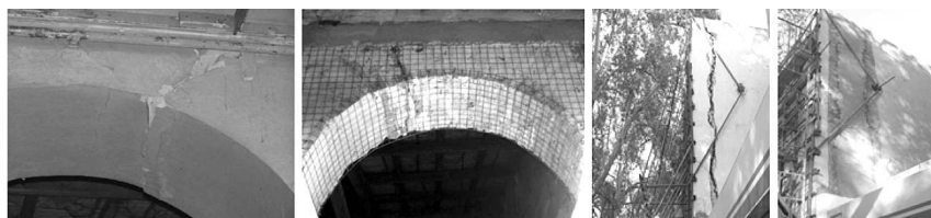
Figura 12.10 – Reparación de daños en arcos (izquierda) y frente (derecha). Fuente: N. Maldonado y Michelini (1999).
