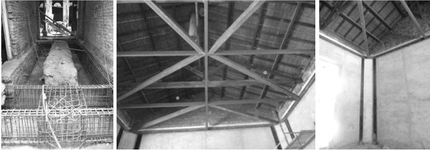
Figura 12.11 – Rehabilitación estructural de fundaciones e incorporación de arriostros. Fuente: N. Maldonado, Martín, I. Maldonado y F. Calderón (2013).
