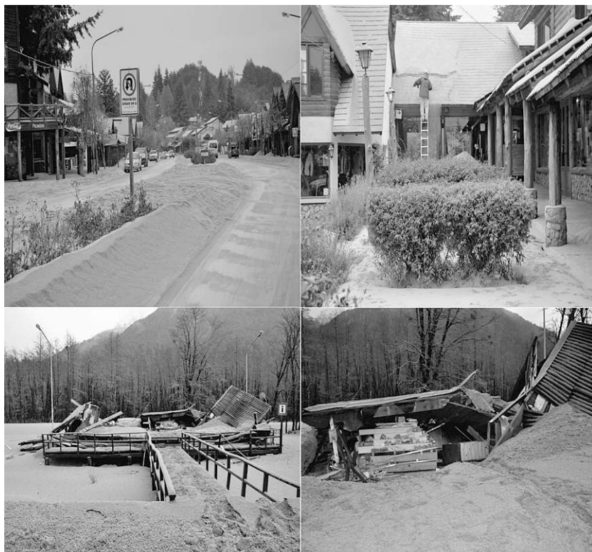
Figura 15.2 – Superior izquierda: vista de la avenida principal de VLA cubierta de ceniza volcánica. Superior derecha: techos cargados de ceniza y una persona realizando limpieza (06/06/2011). Inferior: kiosco en el paso fronterizo Cardenal Samoré – Aduana Argentina – con su techo y estructura colapsada por el sobrepeso de la ceniza volcánica y la nieve (08/06/2011). Fuente: fotos de Villarosa y Outes.
