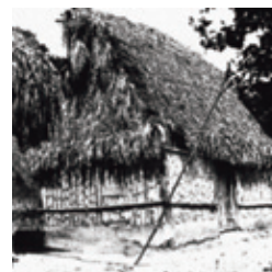
Fig. 9.1. Casa totonaca, con techo de palma y muros de bambú rajado por la mitad en Ojital, Veracruz (foto: Mariana Yampolsky, 1982).
