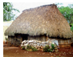
Fig. 9.3. Casa maya en Yucatán. El alto techo inclinado permite a la vez un escurrimiento rápido de la lluvia y los lados redondeados limitan la resistencia a los vientos (foto del autor).
