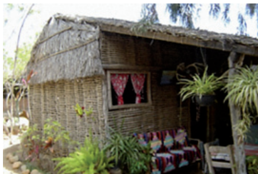
Fig. 9.11. Casa en Baja California, hecha de estera tejida (foto del autor).
